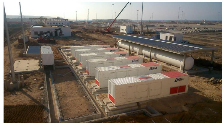
Ilustr. 2: Central en curso de instalación in situ
