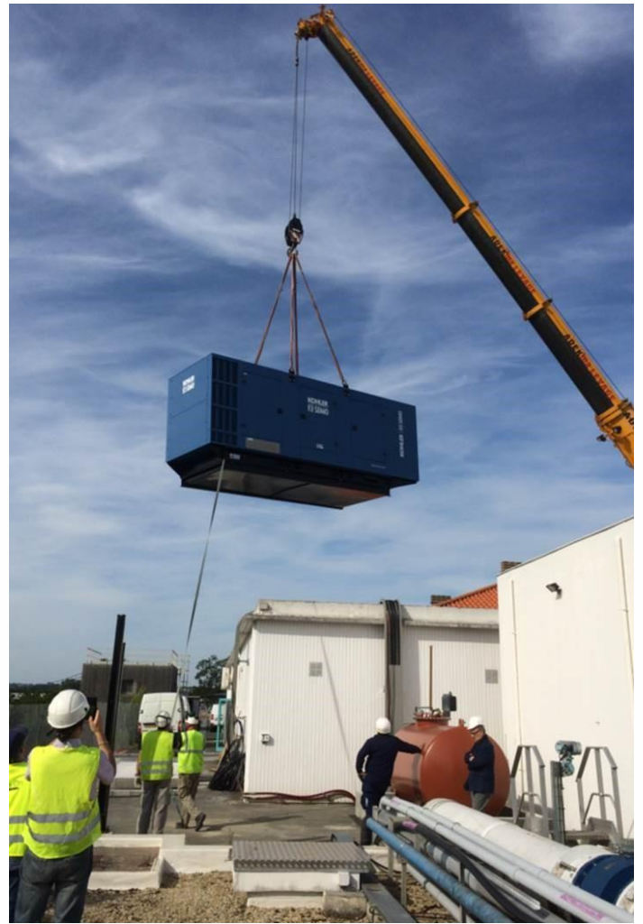
Ilustr. 4: El grupo KD900 en curso de instalación en la planta
