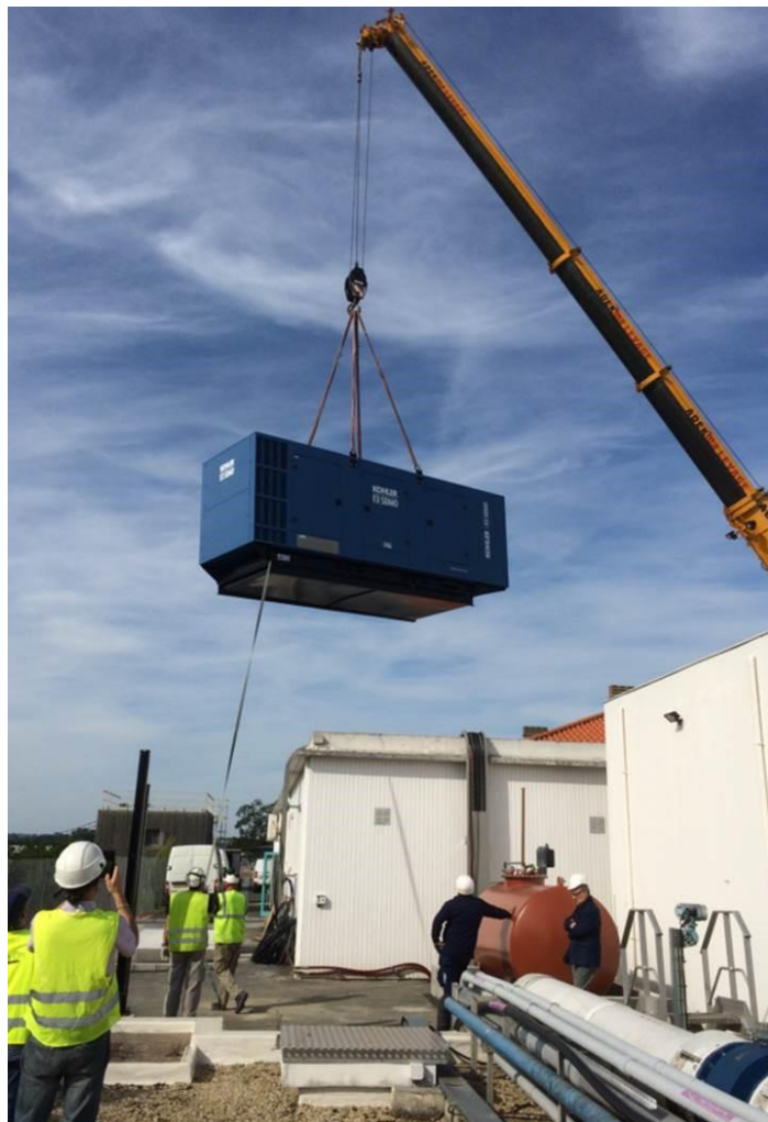
Illus. 4 : Le groupe KD900 en cours d'installation sur le site
