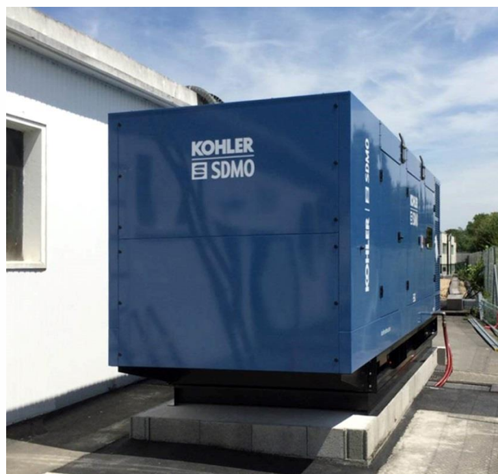
Illus. 2 : Le groupe électrogène KD900 en version capot à l'usine des eaux d'Ancenis.
