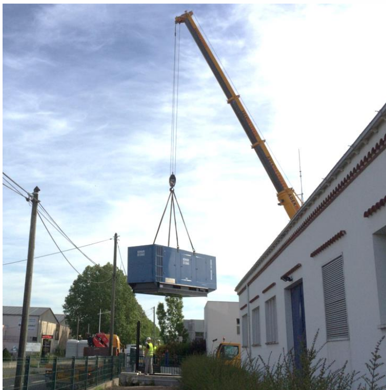
Illus. 3 : Le groupe KD900 en cours de manutention sur le site
