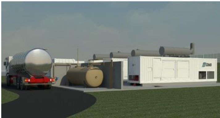
Illus. 1. Plan d'installation des quatre groupes électrogènes
